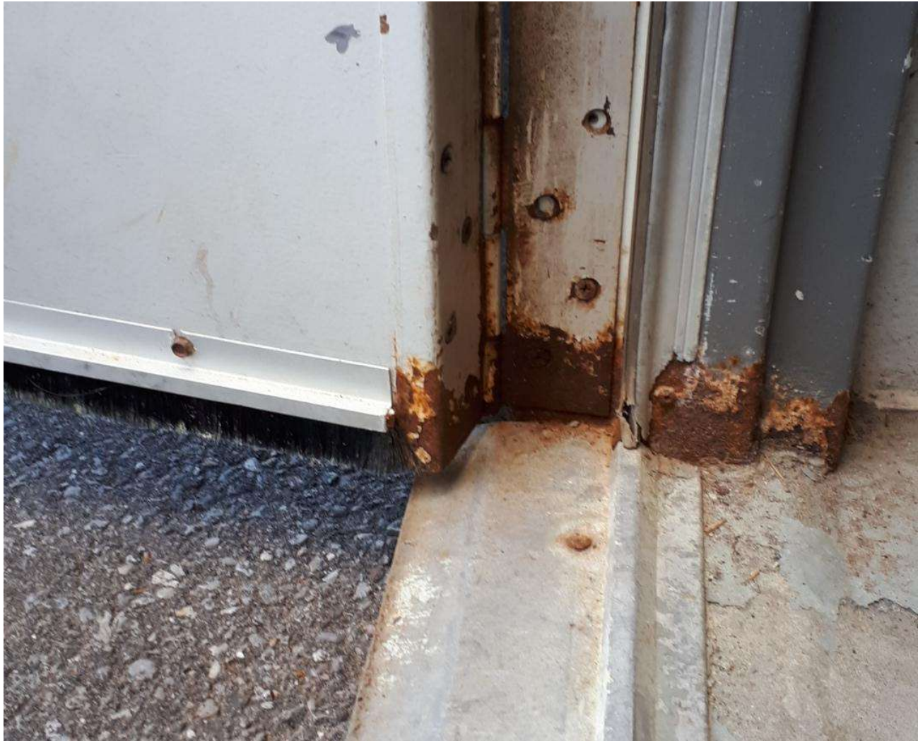
Exterior door 2.jpeg
